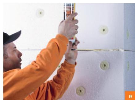
На углах проемов утеплитель устанавливается в виде Г-образных элементов. По желанию их можно выполнить из МВП с пределом прочности при растяжении перпендикулярно к лицевым поверхностям не менее 15 кН/а.
