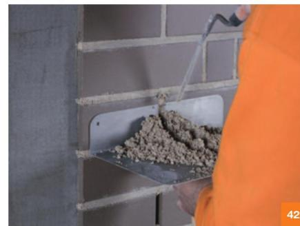
После неполного схватывания клея (спустя 30-60 минут) произвести расчистку шовов на всю глубину от излишков клея.
