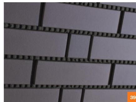
На тыльную поверхность плитки нанести клей RKS сплошным слоем толщиной 1 мм.
