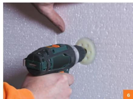
Зафиксировать плиты утеплителя на стене при помощи тарельчатого элемента EJOT STR-H или TERMOCLIP СТЕНА-3. Расход ~ 5-6 шт./м<sup>2</sup>.
